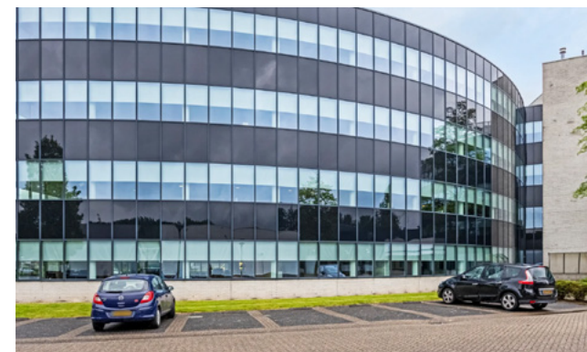
Energie label A Turn-key opleveringsniveau 200 parkeerplaatsen
